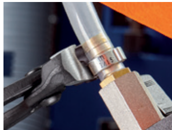
10 98 I220: Abdichten Schlauchanschluss an Zentralschmierung
