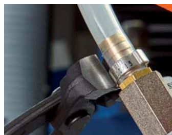
10 98 I220: Ermetizzazione raccordo tubo sulla lubrificazione centralizzata
